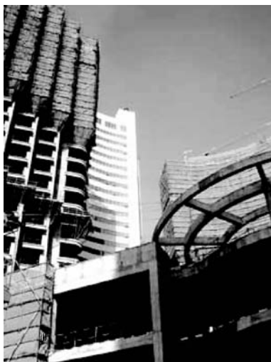
图 6-1 数码港的身，位于香港路上的一栋未完成建筑
